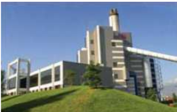
Exemple d'une chaufferie
